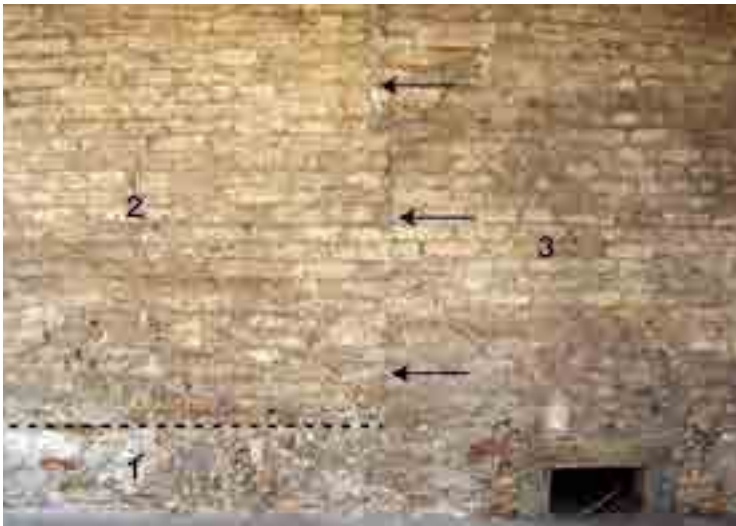
Fig. 9. Santa Giustina, particolare del perimetrale sud con l'alzato in laterizi romani di reimpiego (2), tagliato per realizzare l'accesso all'ipogeo e successivamente tamponato (3)
