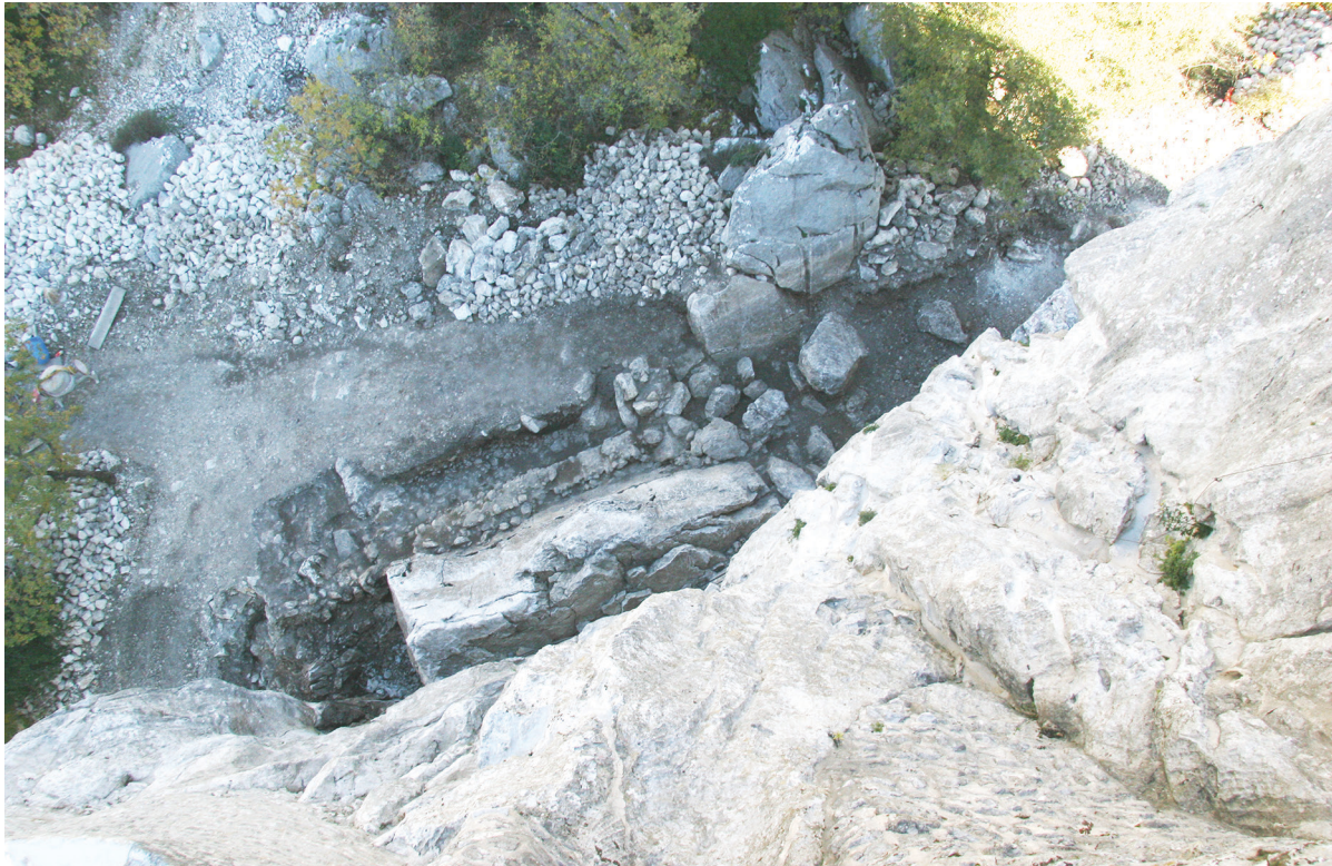
SLIKA 16. Pogled na sondu 4; temelj južnog zida moguće obrambene kule, 2013. (foto: N. Topić, Omega engineering d.o.o. Dubrovnik).
