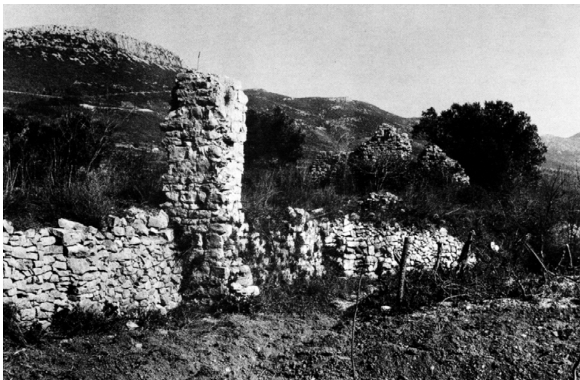
SLIKA 2. Ostaci kasnoantičkih zgrada villae rusticae na Mirima u Kaštel Novom (foto: Z. Buljević)
