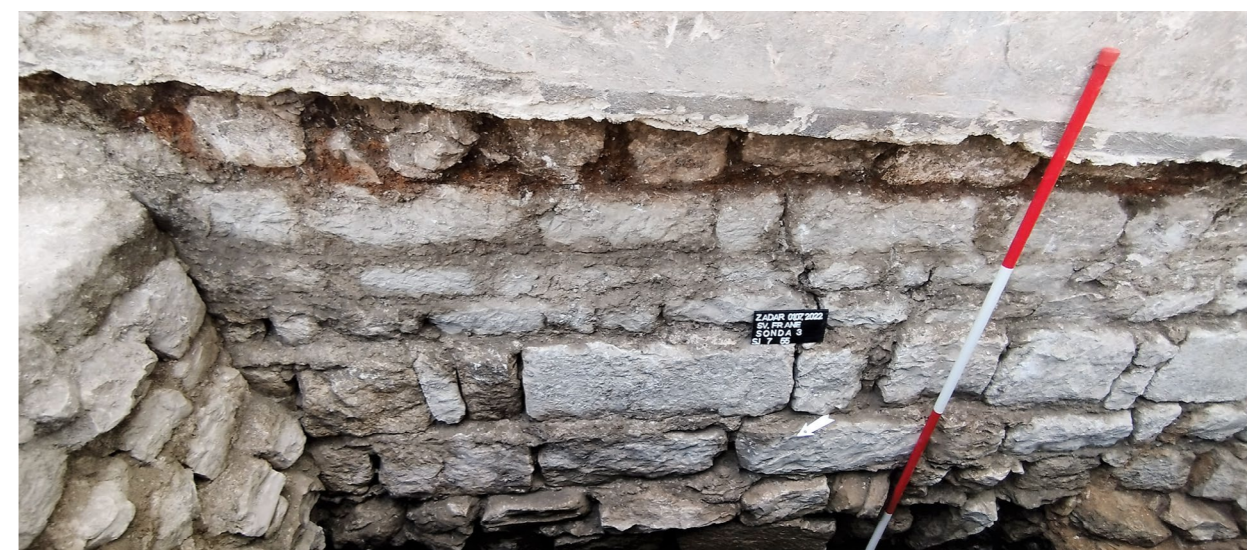
Temeljna stopa zapadnog samostanskog zida (foto: L. Bogdanić) Footing of the western monastery wall (photo: L. Bogdanić)
