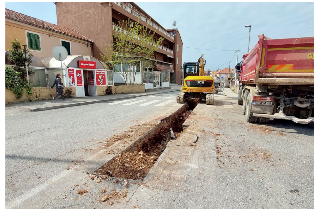
Pogled na kanal u ulici Put Kotlara (foto: L. Bogdanić) View of the channel in Put Kotlara Street (photo: L. Bogdanić)
