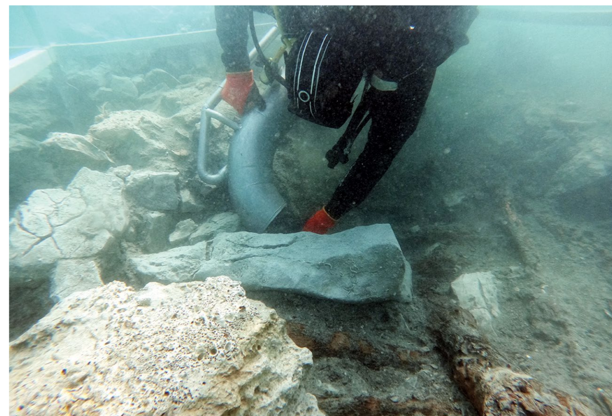
Iskop drvenih elemenata konstrukcije velikog mola (foto: I. Radić Rossi) Excavation of the wooden elements of the large pier construction (photo: I. Radić Rossi)
