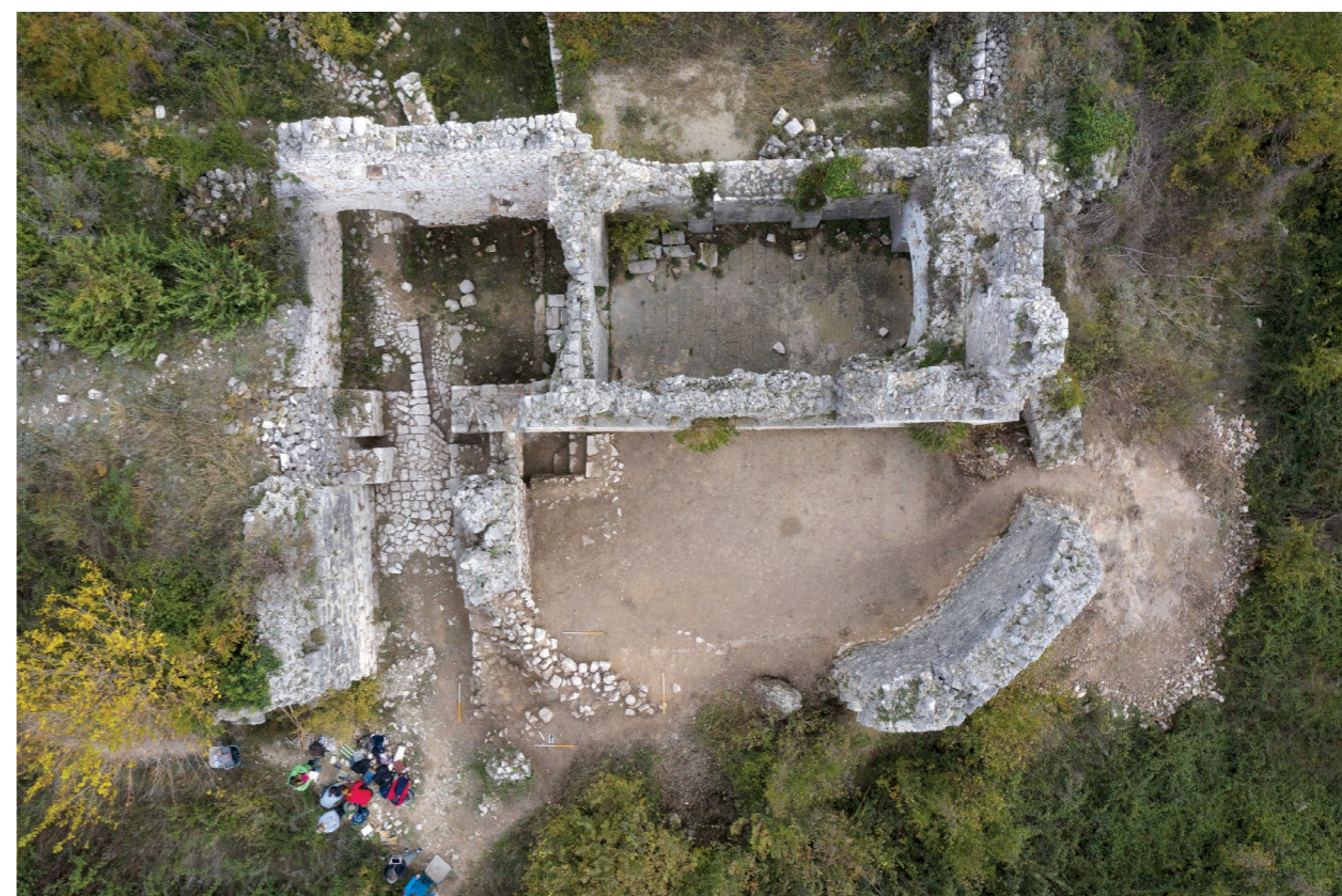
Lokalitet nakon završenih radova (foto: J. Šučur) Site after the completion of works (photo: J. Šučur)
