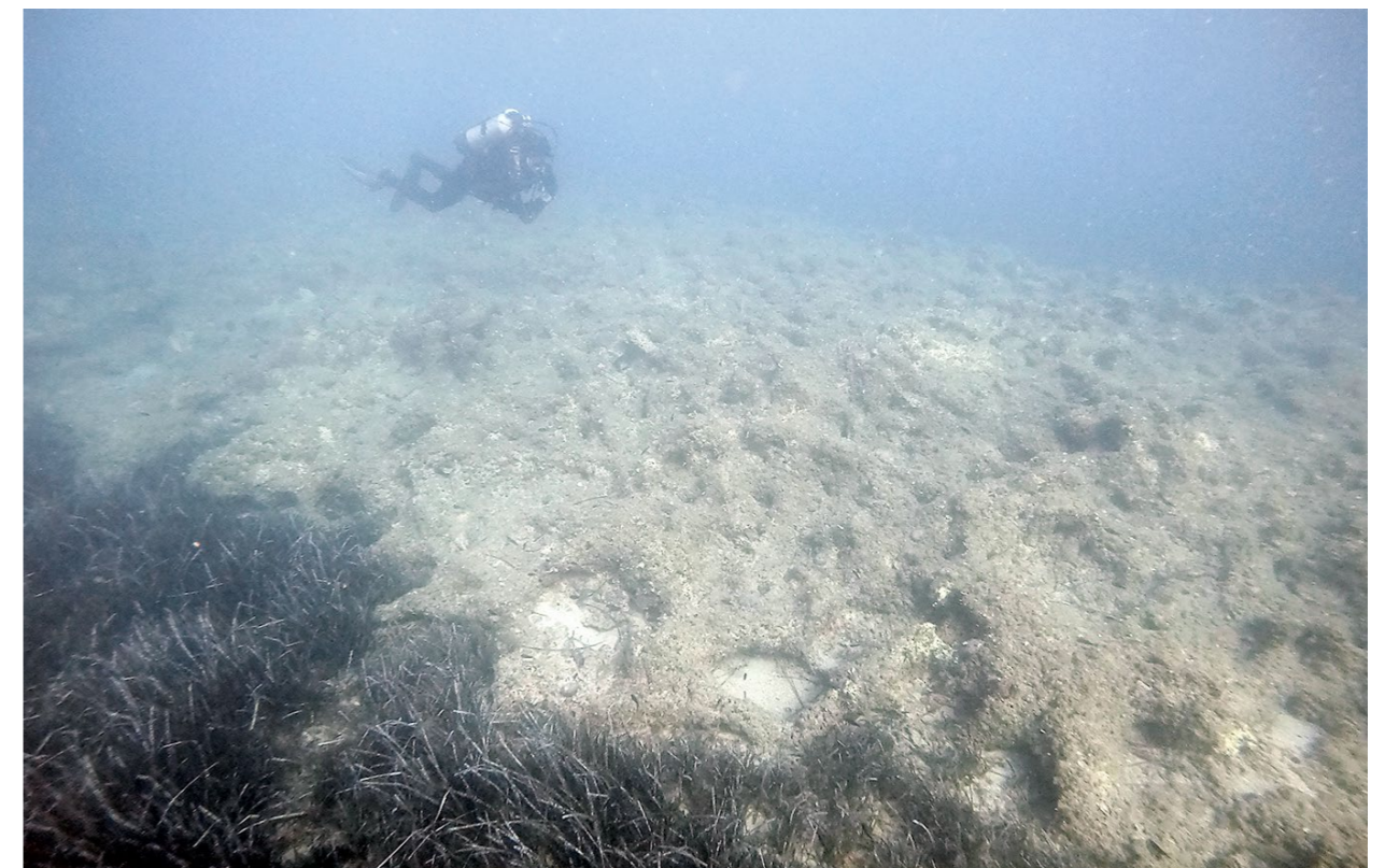
Komunikacijski nasip u podmorju Bogutovca (foto: M. Parica) Communication embankment in the Bogutovac seabed (photo: M. Parica)
