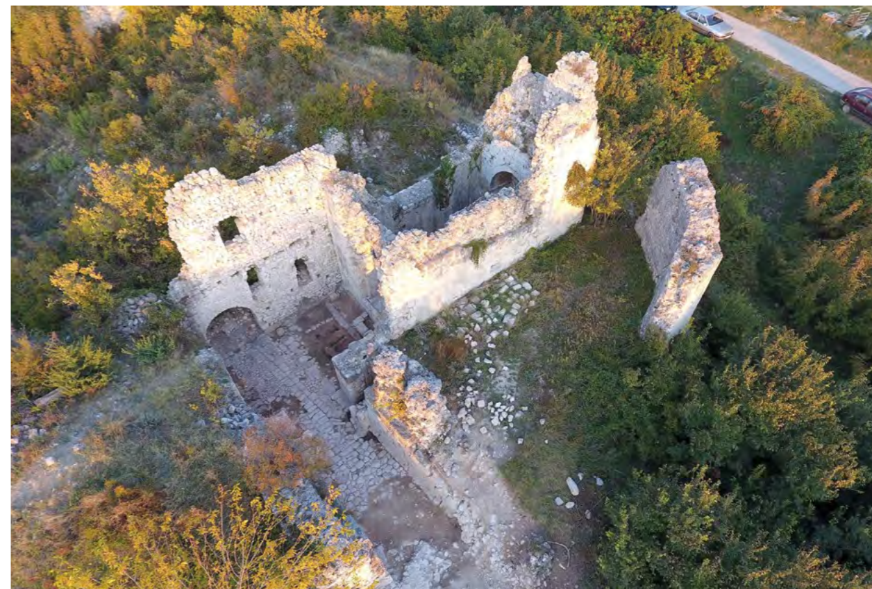
Ulazni kompleks prije početka istraživanja (foto: J. Šučur) Entrance complex before the beginning of the investigations (photo: J. Šučur)
