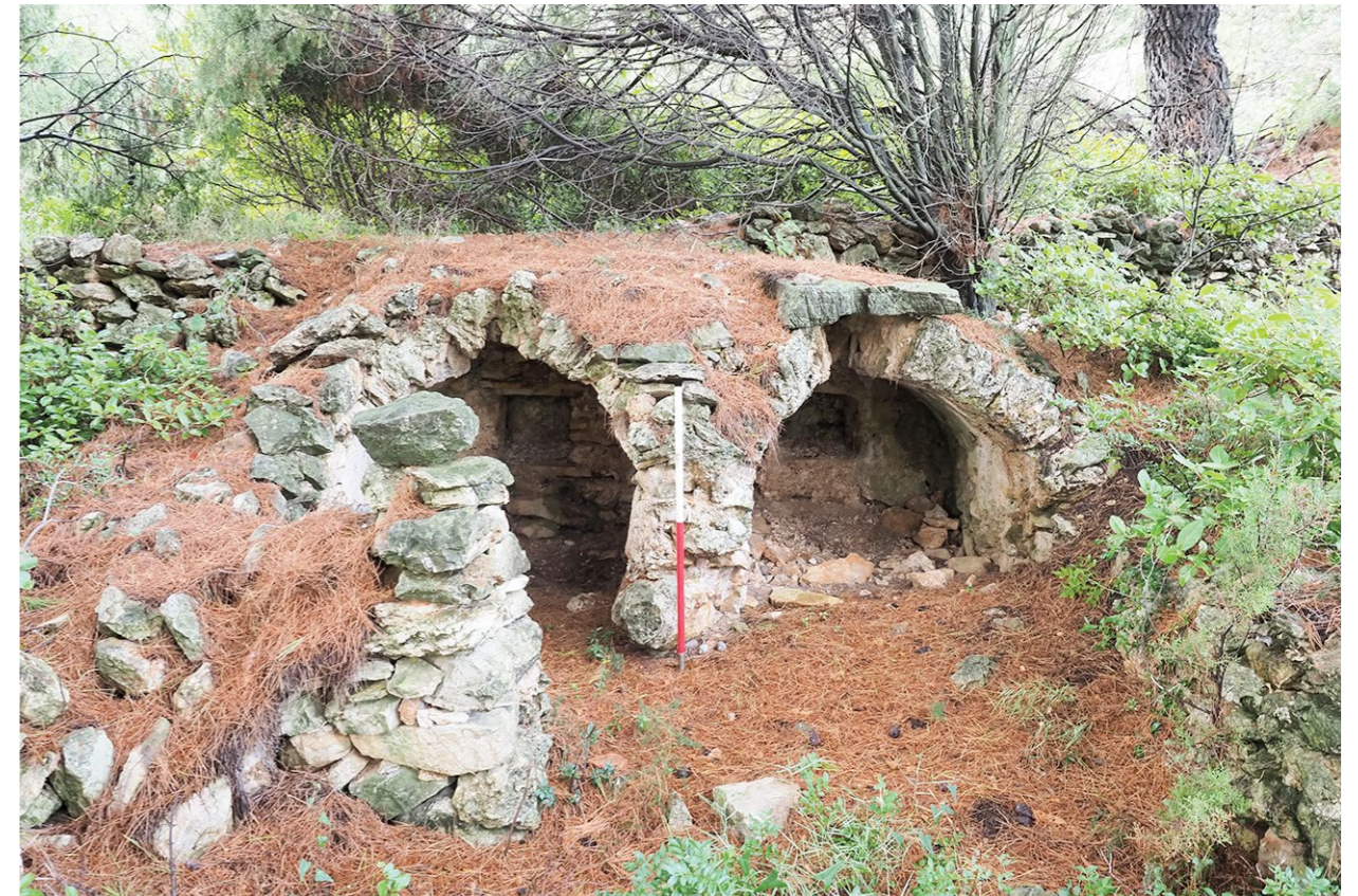
Grobnica na svod prije arheoloških iskopavanja (foto: E. Visković) Vaulted tomb before archaeological excavations (photo: E. Visković)
