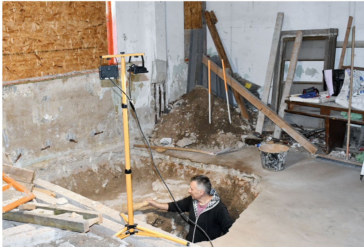
..... Pozicija 1, sondažna jama 1 za vrijeme istraživanja (foto: N. Ćuk) ..... Position 1, trial pit 1 during excavation (photo: N. Ćuk)
