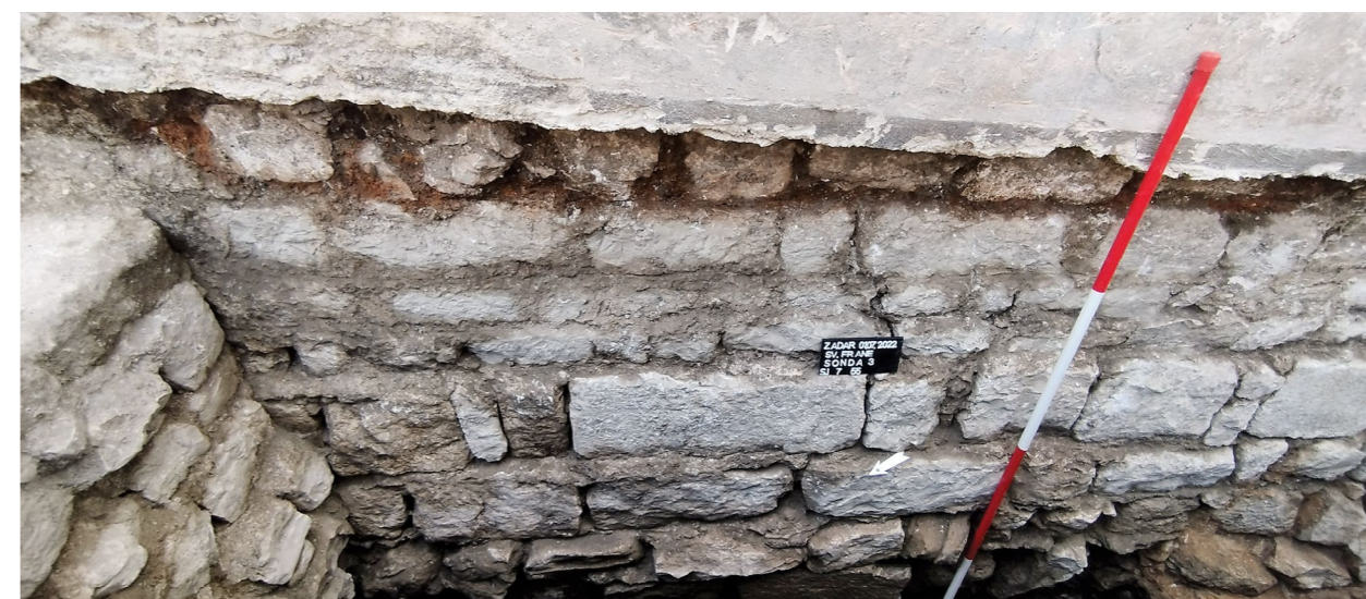
Temeljna stopa zapadnog samostanskog zida (foto: L. Bogdanić) Footing of the western monastery wall (photo: L. Bogdanić)
