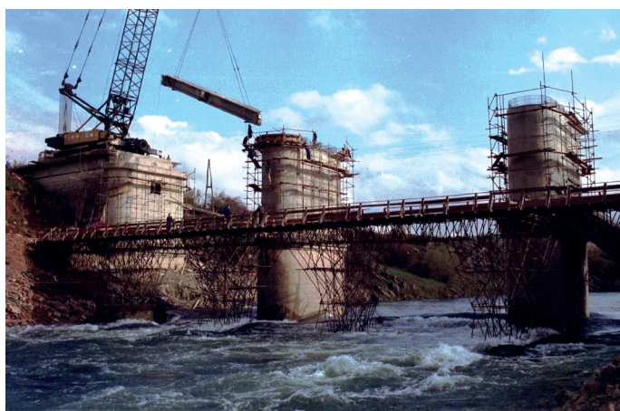
Slika 12. Gradnja drugog betonskog mosta u jesen 1992., u prvom planu provizorni most (Izvor: Čuljat, Marko. Lika priča ljepotom. 2000.)
