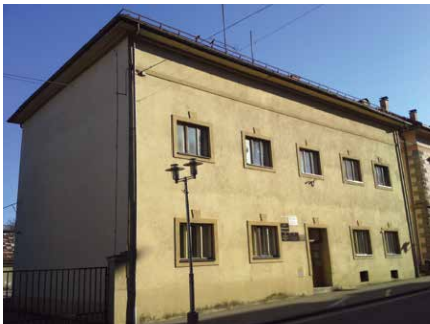
Sl. 14. Stan zapovjednika, kasnije zgrada zapovjedništva obrane u NDH – danas Šumarija Gospić u Kaniškoj 15 – glavno ulično pročelje, 1957. (foto: V. Šulentić, 22. 5. 2016.)
