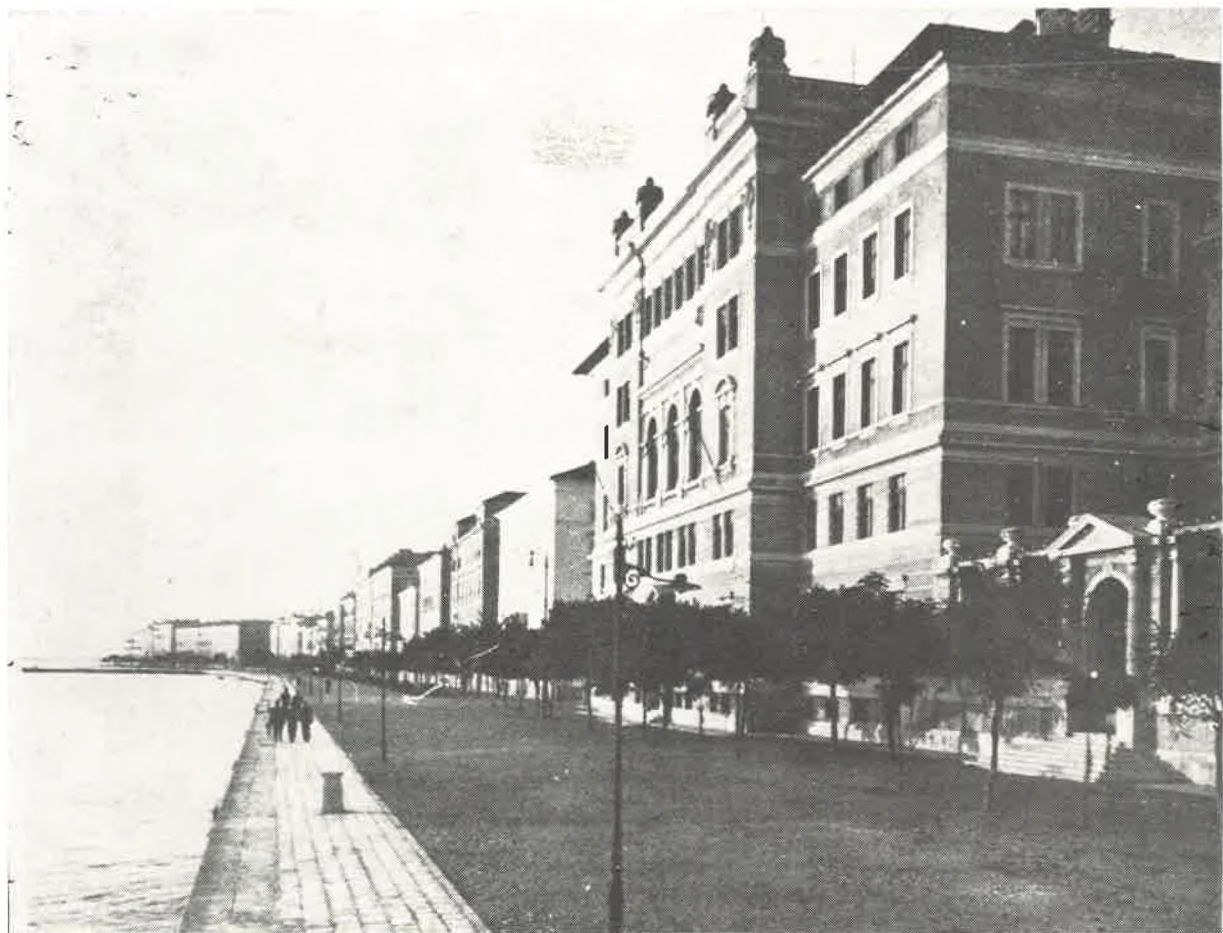
Pogled na Novu obalu nakon izgradnje Liceja.
